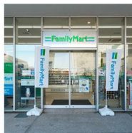
本棟3F ファミリーマート コンビニエンスストア
